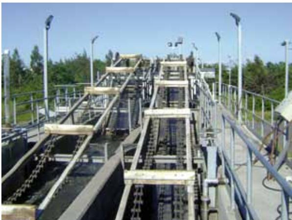
Figura 5. Desarenador con limpieza mecánica. PTAS Los Ángeles (Chile). Foto: Cortesía Leonardo Vera.
