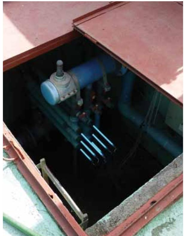
Figura 21. Sistemas terciarios de desinfección. Sistema de desinfección con cloro mediante cámara de contacto (izquierda) PTAS Contulmo y desinfección por UV (derecha) PTAS Villa Laja.
