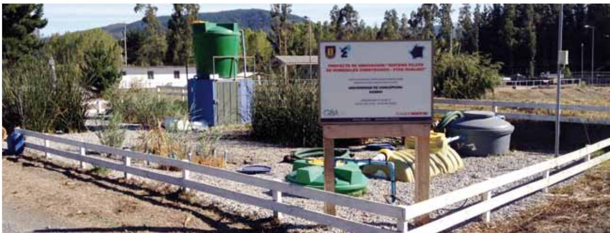
Figura 20. Sistema piloto de humedales construidos en la PTAS de Hualqui (Proyecto GIBA-UDEC en convenio con ESSBIO S.A.).
