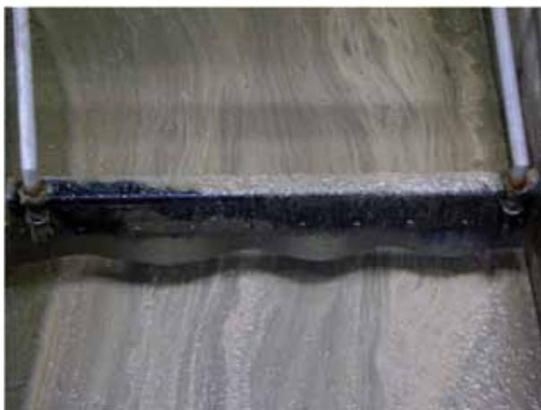
Figura 7 . Eliminación de sustancias flotantes del agua servida.
