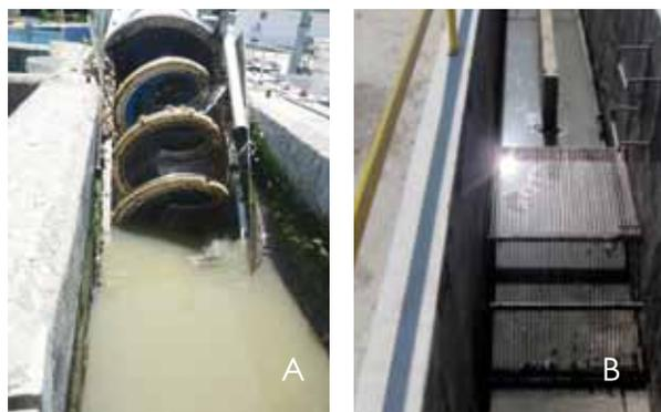
Figura 4 Alternativas de desbaste. a) Tamiz rotatorio, b) Rejilla manual. Fotos cortesía de Leonardo Vera.
