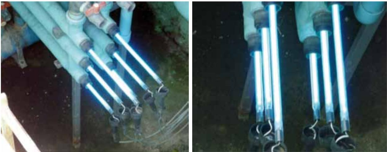
Figura 4. Fotografía de sistema de desinfección UV de reactor cerrado con lámparas en paralelo al flujo. Sistema instalado en la Planta de tratamiento descentralizada de la localidad de Villa Laja, comuna de Laja. Esta planta de tratamiento consiste en un sistema de biodiscos como tratamiento biológico de aguas servidas que recibe el agua servida de aproximadamente 130 casas. Estas lámparas poseen una vida útil de aproximadamente 10.000 horas (Foto tomada en Mayo del 2014).
